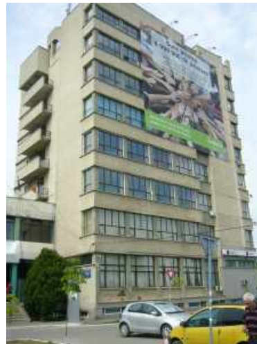
U.T. Iasi La Faculté D'Ingénierie chimique Façades et fenêtres en aluminium
