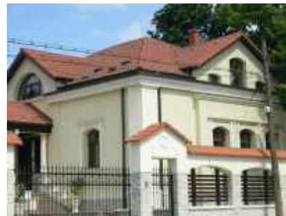
Bâtiment résidentiel, Iasi Fenêtres et portes en PVC
